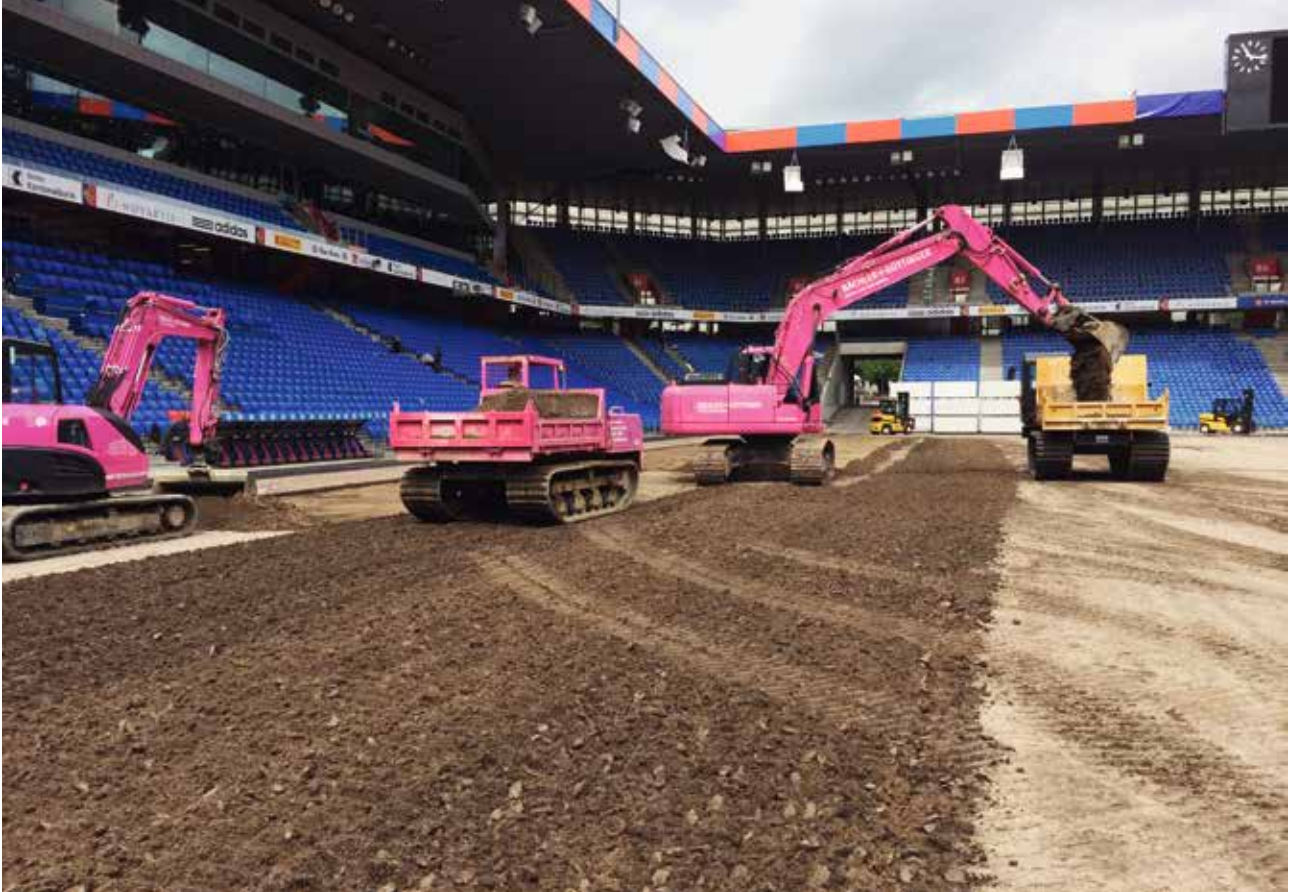
Baustelle: Rasensanierung inklusive Service-Ring
